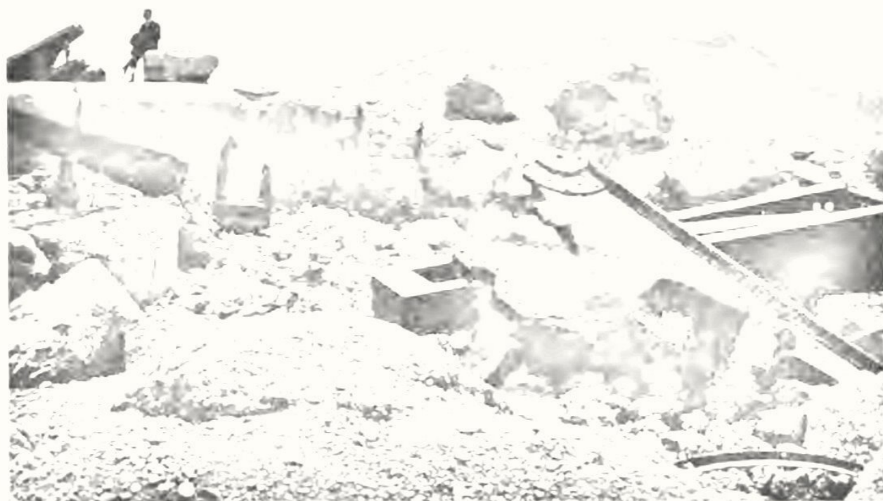
Разрушеніе на батарее.
