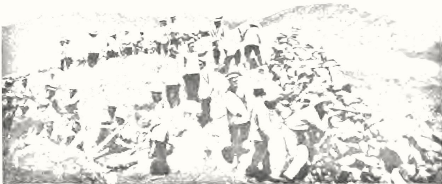
Постройка траншеи на Юпилазѣ.
