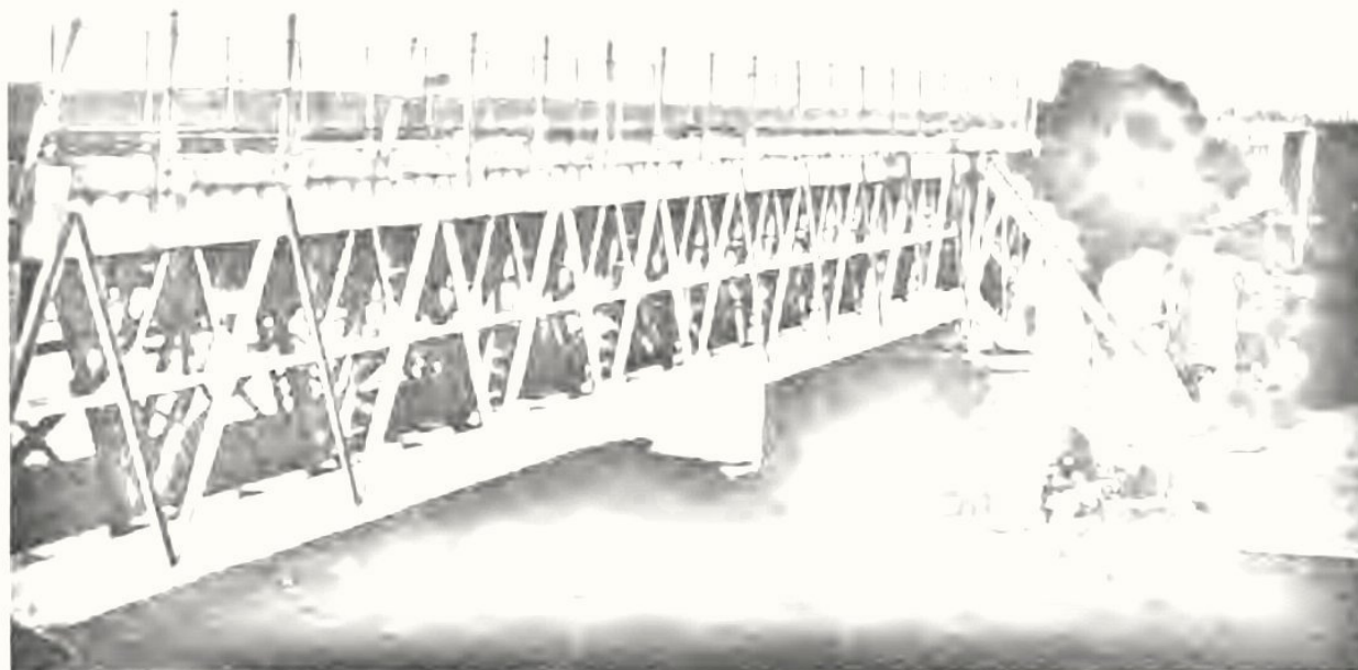
Взрывъ жел.-дор. моста.
