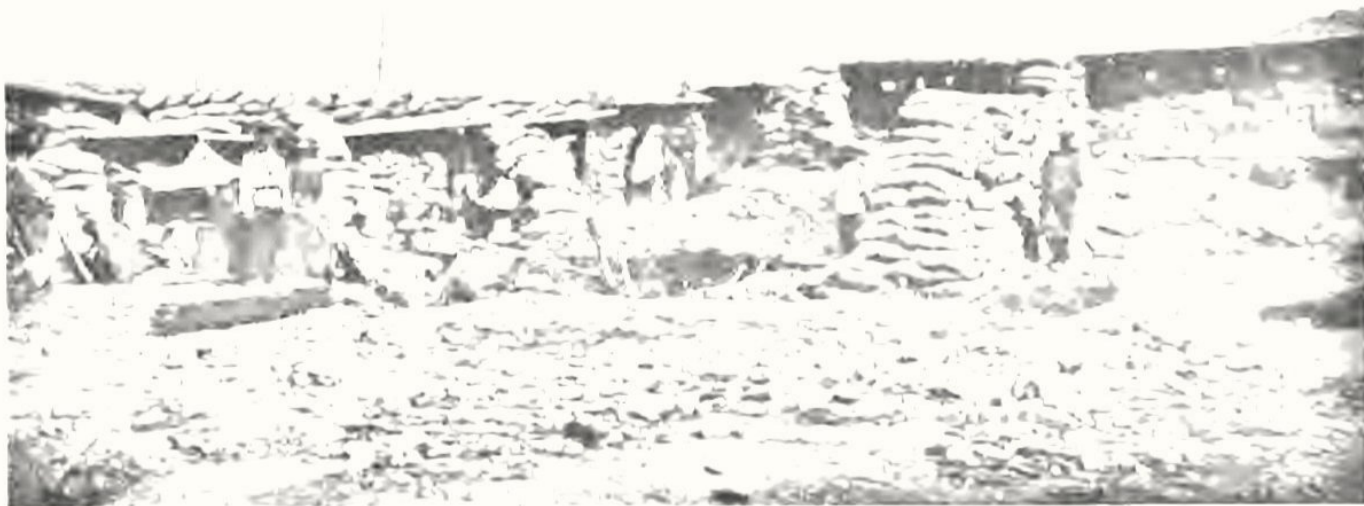
Люнетъ противъ редута № 1. Минныя работы.
