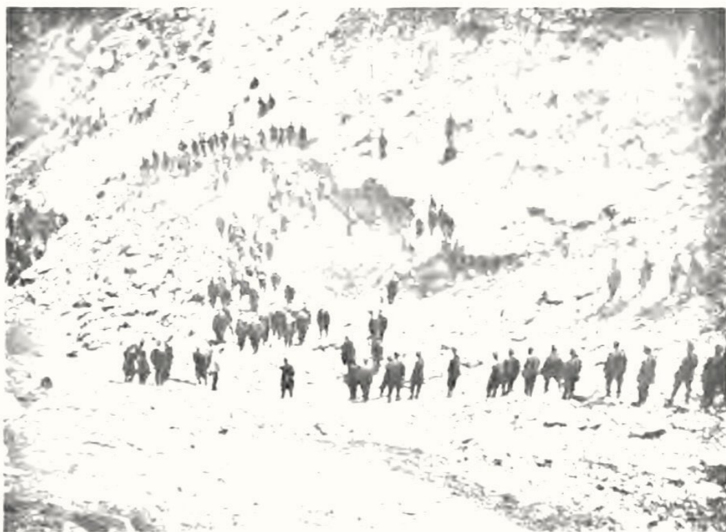
Работы по укрѣпленію Ляотешаня.
