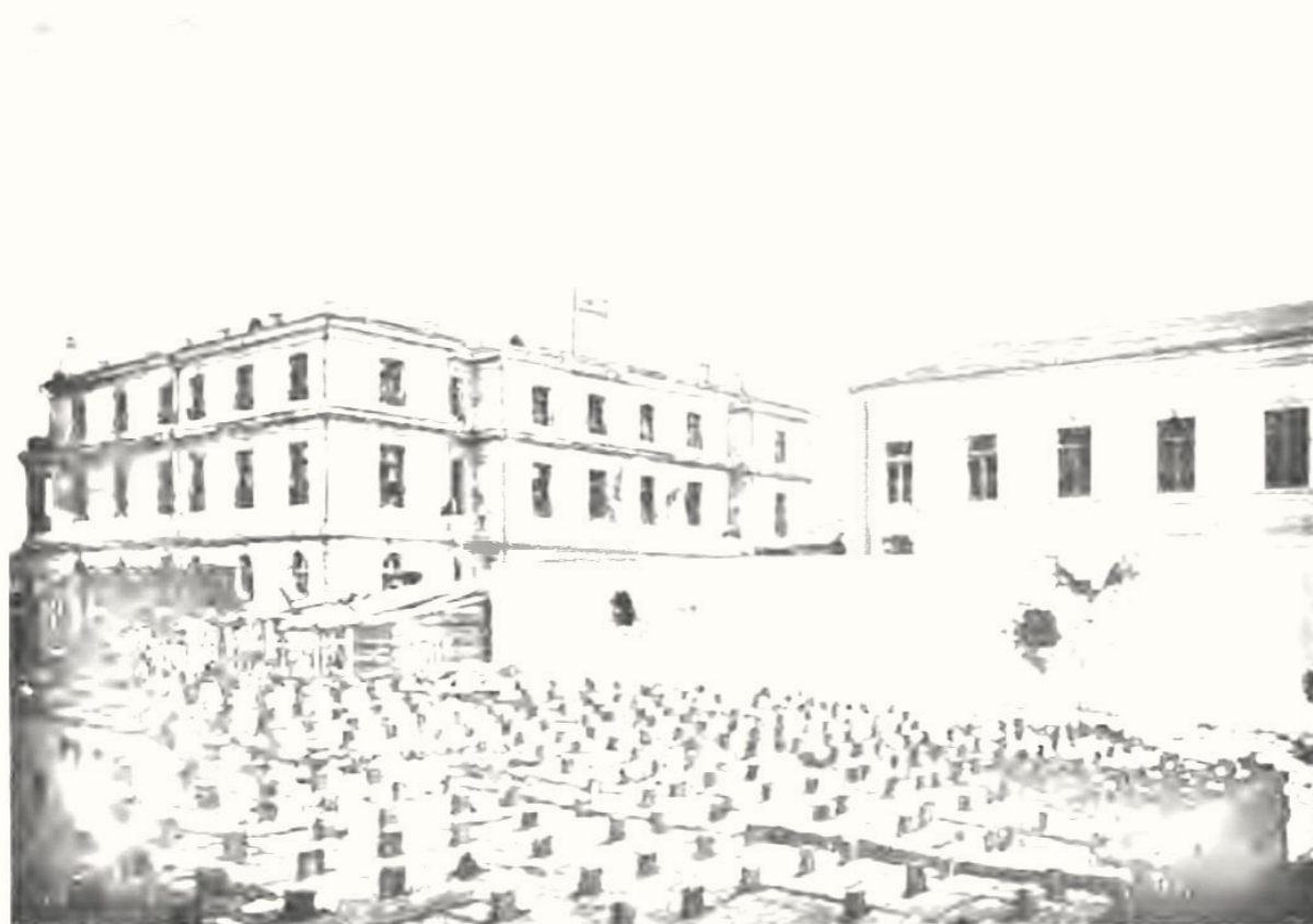
Поврежденія въ госпиталѣ.
