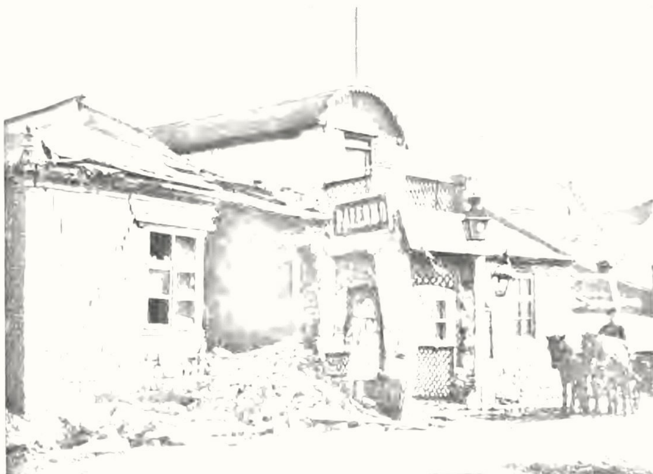
Разрушенія отъ бомбардировки.
