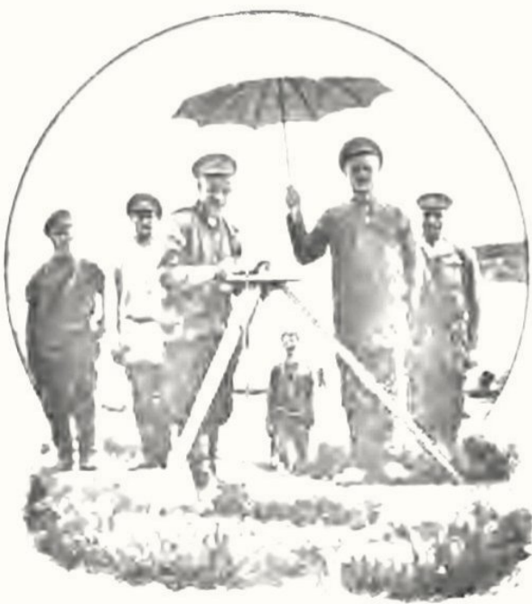
Работы по съемкѣ.
