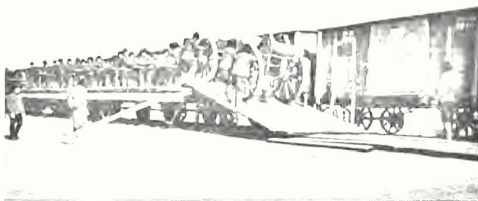
Спускъ осадныхъ орудій съ платформы.
